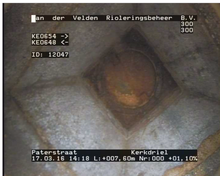
7.60 m1 Foto 031704012: Eindknoop Rioolput KE0648
