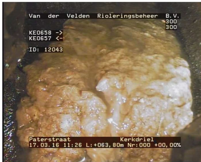
63.80 m1 Foto 031728512: Bezonken afzettingen 5% < belemmering buisdoorsnede <= 10%
