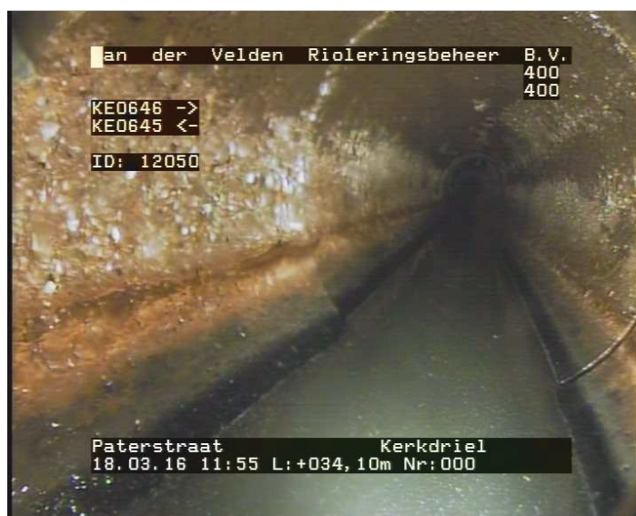
34.10 m1 Foto 031813912: Verplaatste verbinding Radiaal
