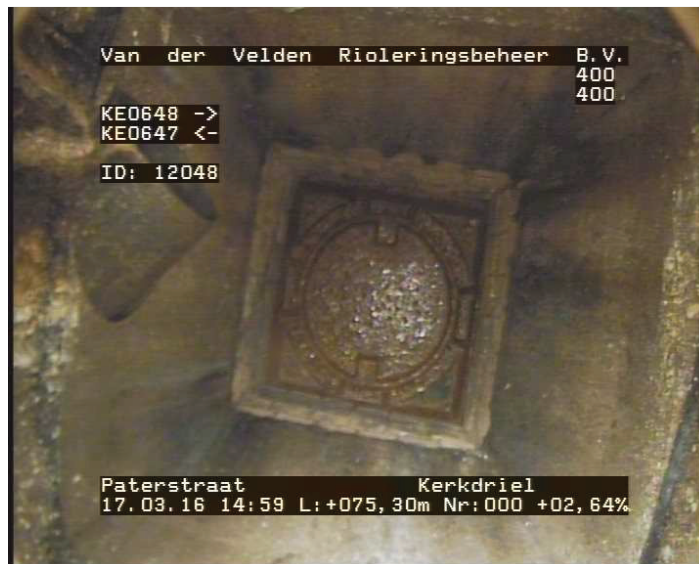
75.30 m1 Foto 031707612: Eindknoop Rioolput KE0647
