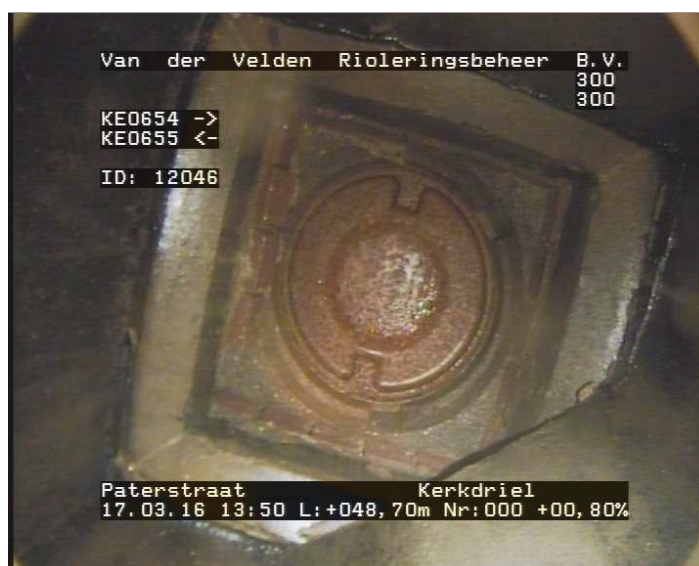
48.70 m1 Foto 031703412: Eindknoop Rioolput KE0655
