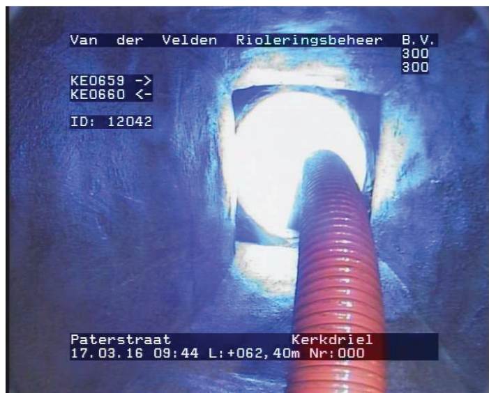
62.40 m1 Foto 031726512: Eindknoop Rioolput KE0660
