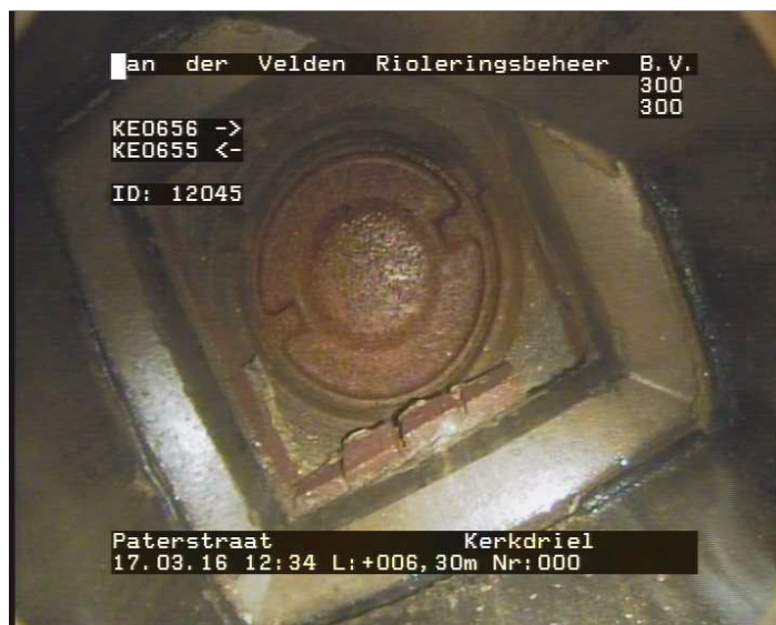
6.30 m1 Foto 031701912: Eindknoop Rioolput KE0655
