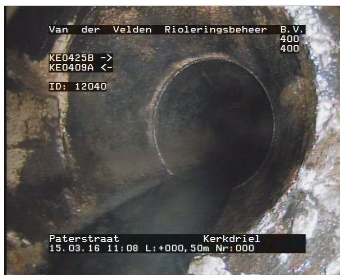
0.50 m1 Foto 031521912: Kromming in het riool B=Horizontaal
