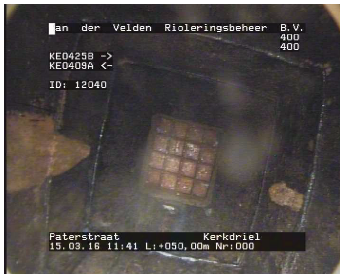
50.00 m1 Foto 031524312: Eindknoop Rioolput KE0409A
