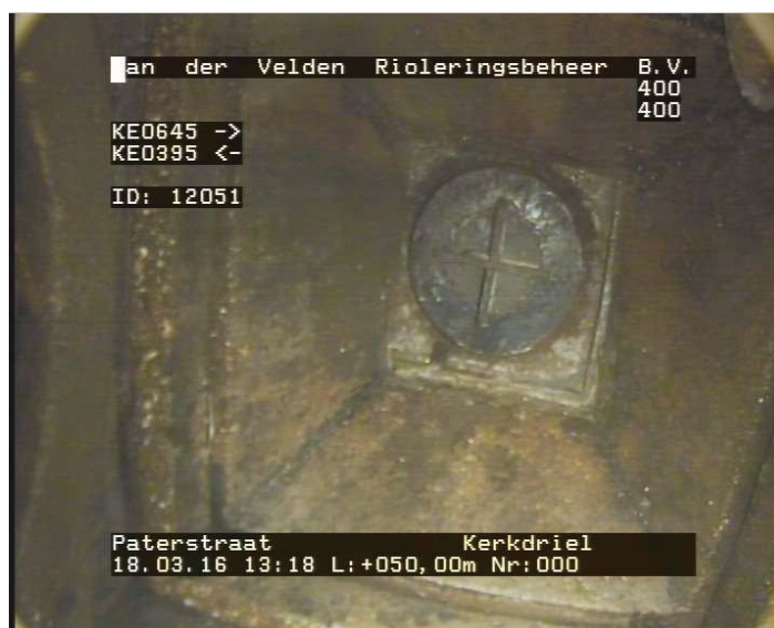
50.00 m1 Foto 031816512: Eindknoop Rioolput KE0395
