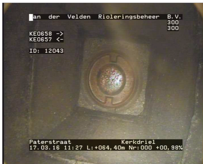
64.40 m1 Foto 031728612: Eindknoop Rioolput KE0657
