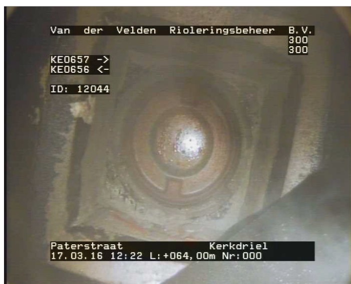
64.00 m1 Foto 031701312: Eindknoop Rioolput KE0656
