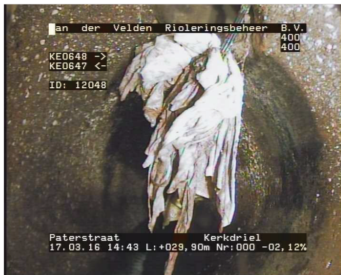
29.90 m1 Foto 031705212: Andere obstakels 5% < belemmering buisdoorsnede <= 10% doekjes hangend aan rubberring afkomstig uit aansluiting!
