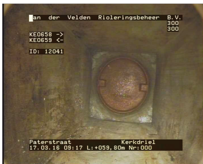
59.80 m1 Foto 031725812: Eindknoop Rioolput KE0659
