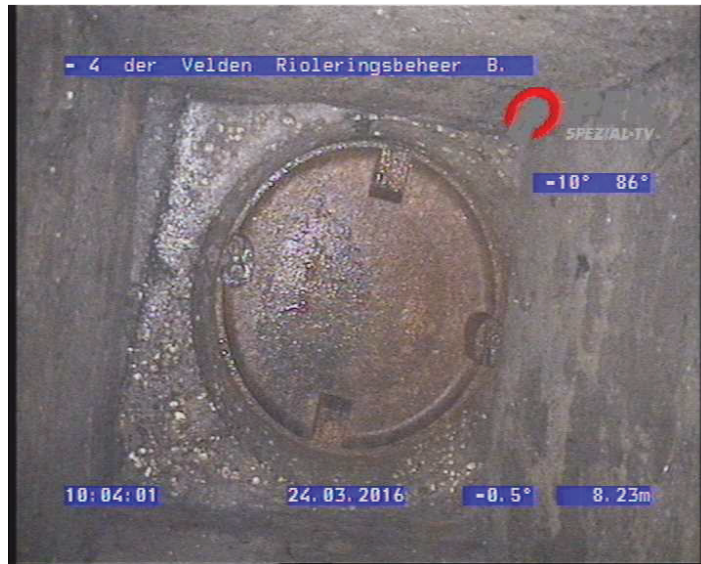
8.23 m1 Foto 032420013: Eindknoop Rioolput KE0389A
