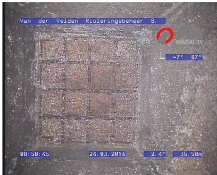
35.58 m1 Foto 032418213: Eindknoop Rioolput KE0401A
