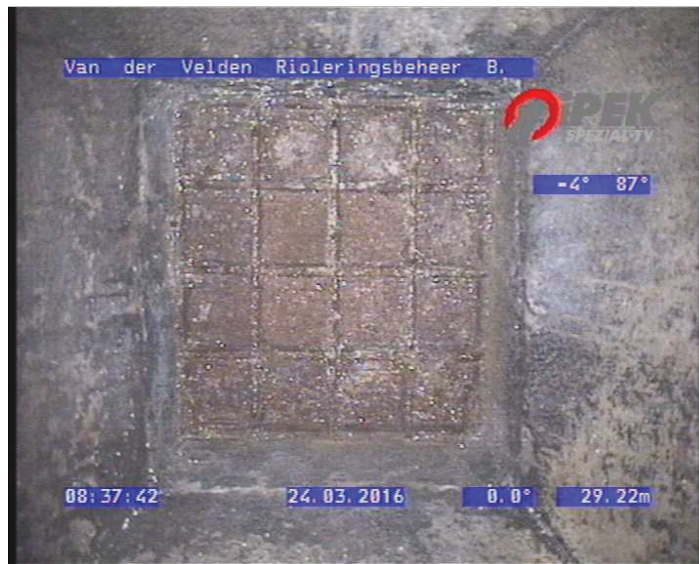
29.22 m1 Foto 032417713: Eindknoop Rioolput KE0401
