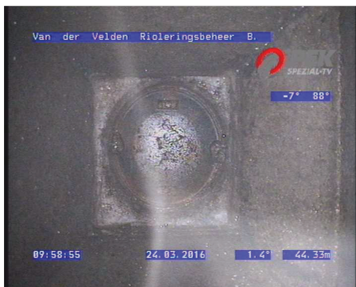
44.33 m1 Foto 032419613: Eindknoop Rioolput KE0406A
