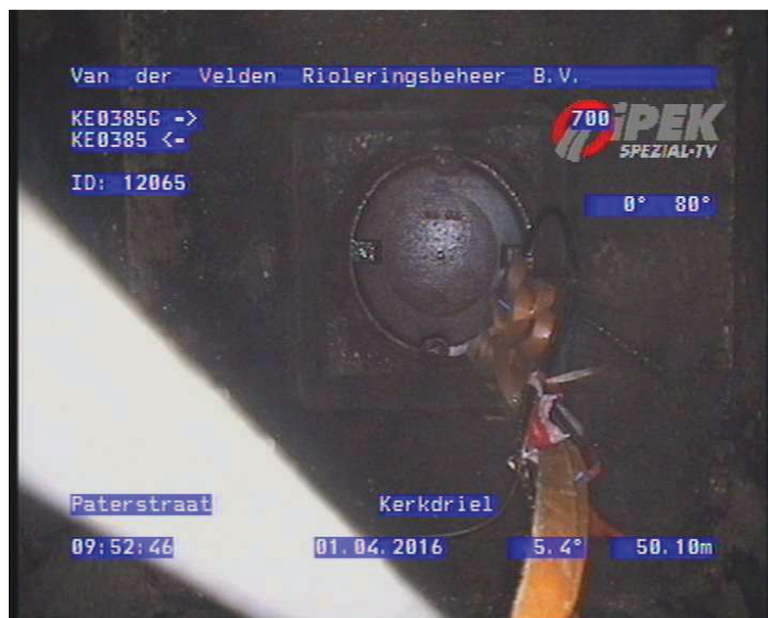
50.10 m1 Foto 040128113: Eindknoop Rioolput KE0385
