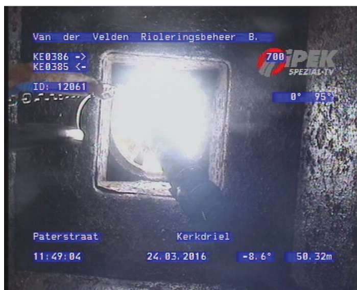
50.32 m1 Foto 032423313: Eindknoop Rioolput KE0385
