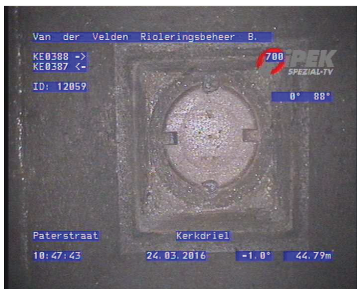
44.79 m1 Foto 032421713: Eindknoop Rioolput KE0387
