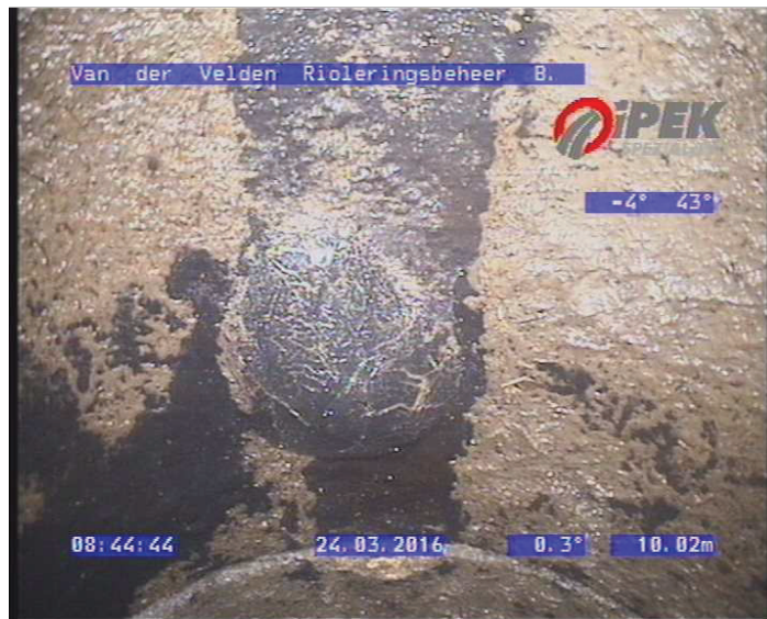
10.02 m1 Foto 032417913: Algemene opmerking Een blaar op de buiswand. Aard van blaar onbekend en onduidelijk!
