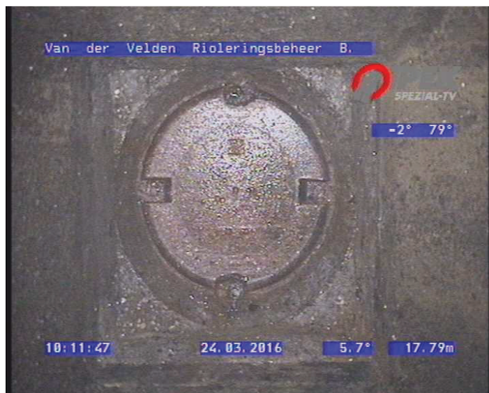
17.79 m1 Foto 032420713: Eindknoop Rioolput KE0389
