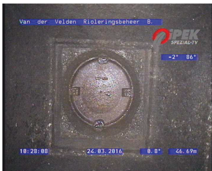
46.69 m1 Foto 032421213: Eindknoop Rioolput KE0388
