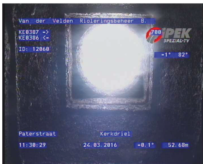
52.68 m1 Foto 032422513: Eindknoop Rioolput KE0386
