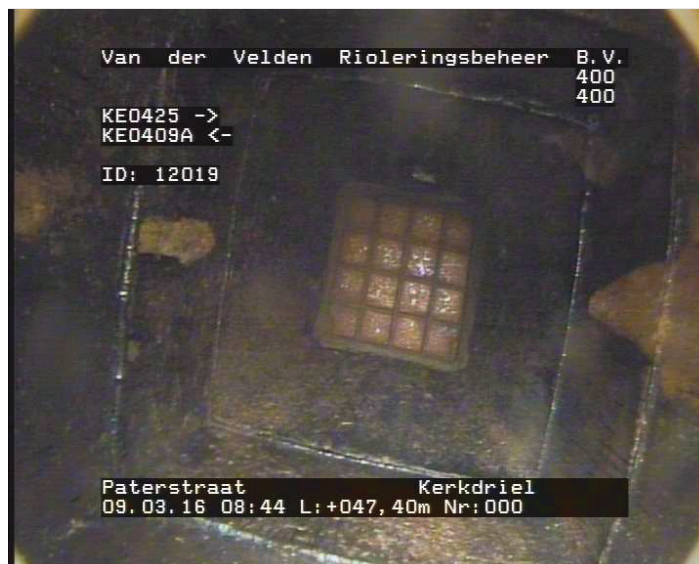
47.40 m1 Foto 030949012: Eindknoop Rioolput KE0409A
